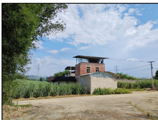
南面 道路、隔路为居民住宅
