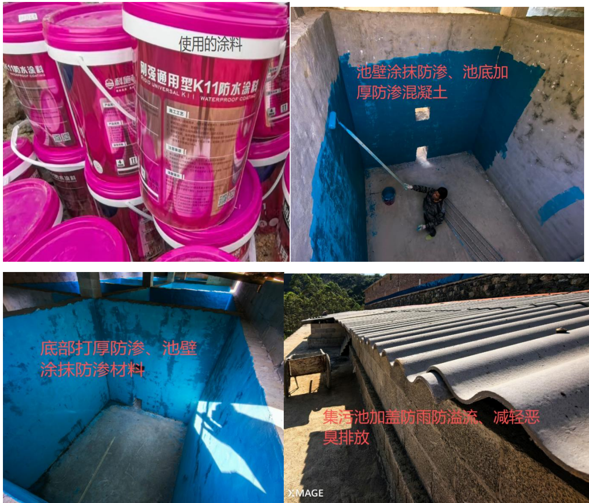
图 2.1.2-2 项目集污池现状
