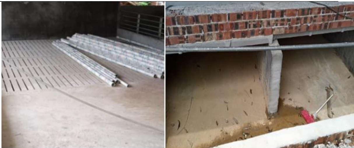
图 2.1.9-3 项目半漏缝、高架网床实景图
