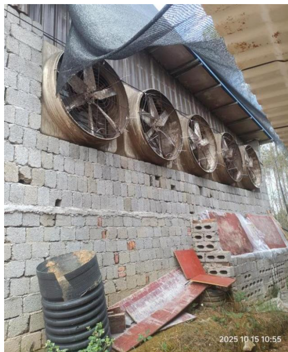
猪舍一侧的引风机-通风换气装置
