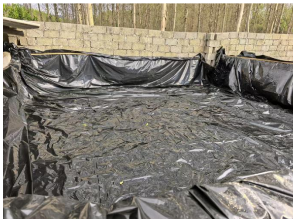
猪舍内的喷雾帘装置 初期雨水池防渗材料
