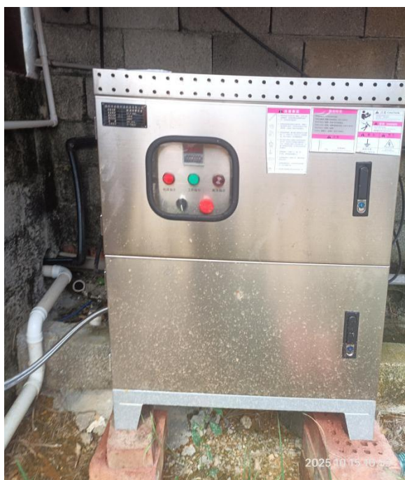
补充安装的喷雾除臭设备
