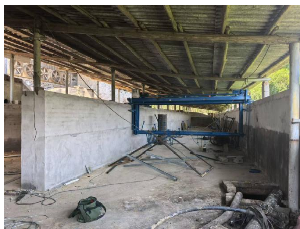
补充建设的异位发酵床设备安装
