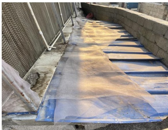
原有工程中猪舍外的循环水池进行加盖
