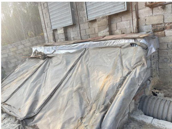
粪污检修口加盖封闭
