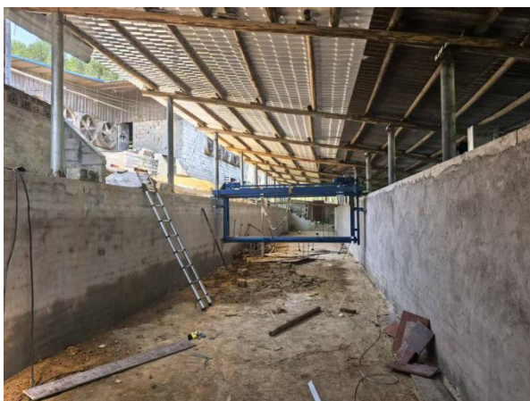
场区内原有异位发酵床设备安装
