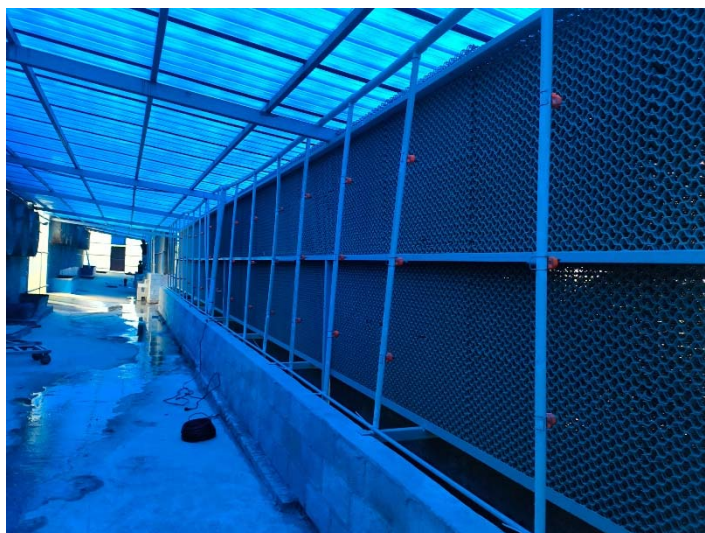
图 3.3-1 风机出口喷淋除臭装置实例图
