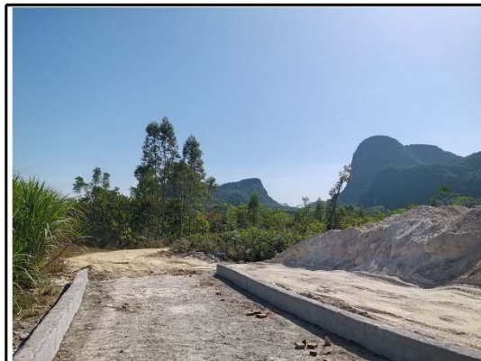
项目南面进场道路及荒地
