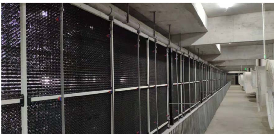
图 6.3-2 水帘除臭墙工程安装实例
