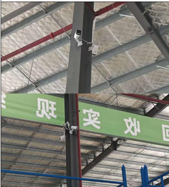
原料贮存区摄像头
