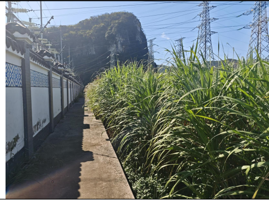
变电站站外植被现状（甘蔗地）
