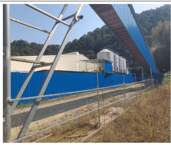
现有工程料塔
