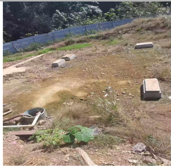
现有工程埋地集污池现状（拟整改）
