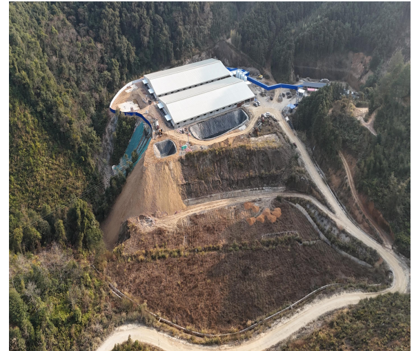
项目场址现状
