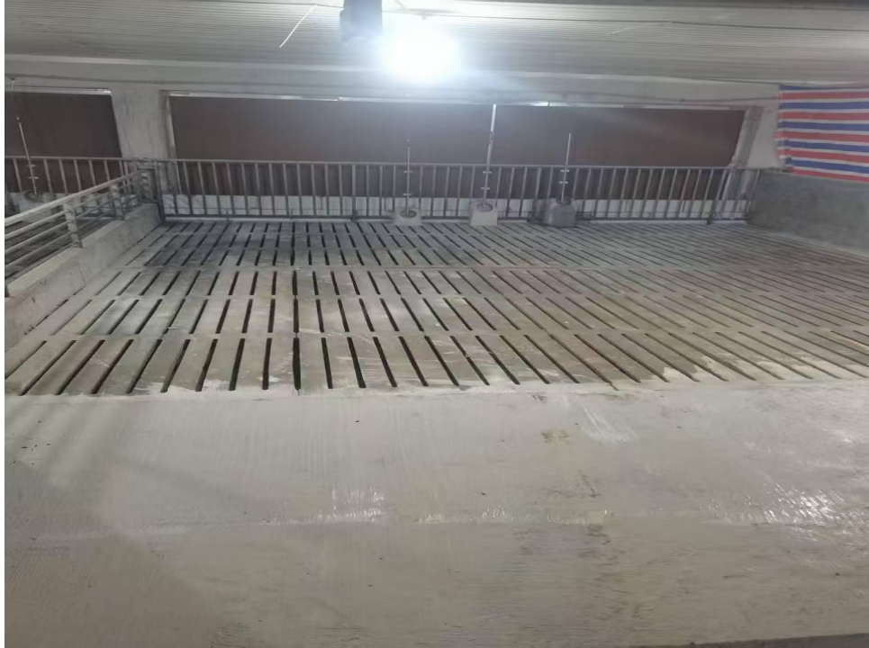
图 2.3-2 猪舍漏缝地板
