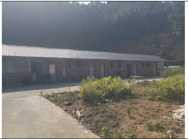
现有工程生活管理区
