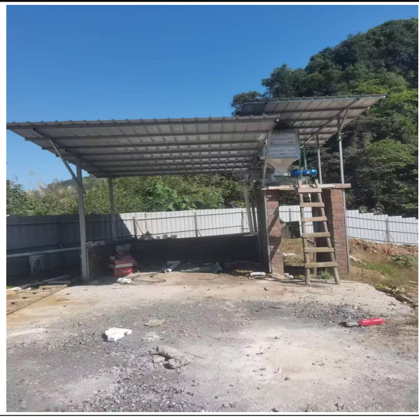
现有工程固液分离机及堆粪棚现状（拟拆除）
