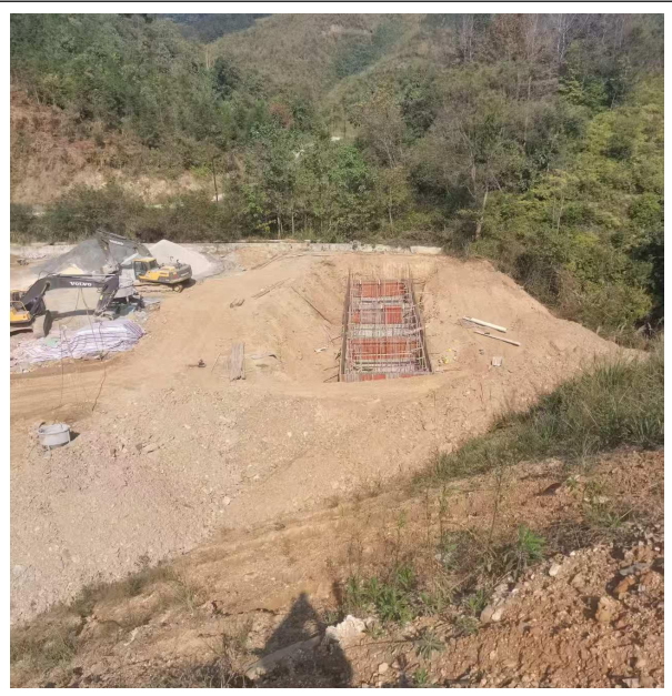
粪污暂存池在建中
