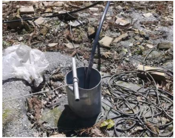
现有工程跟踪监测井
