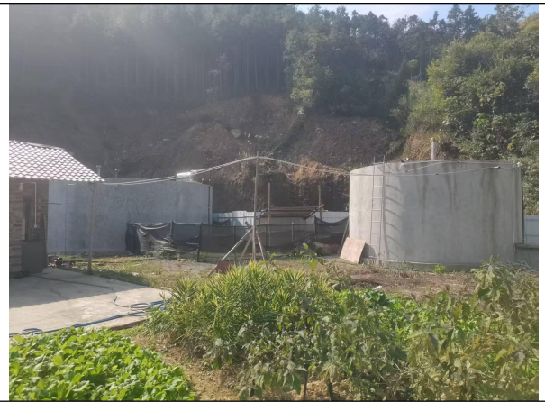
现有工程水塔
