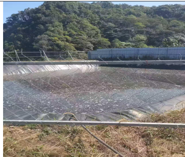
现有工程沼液贮存池现状
