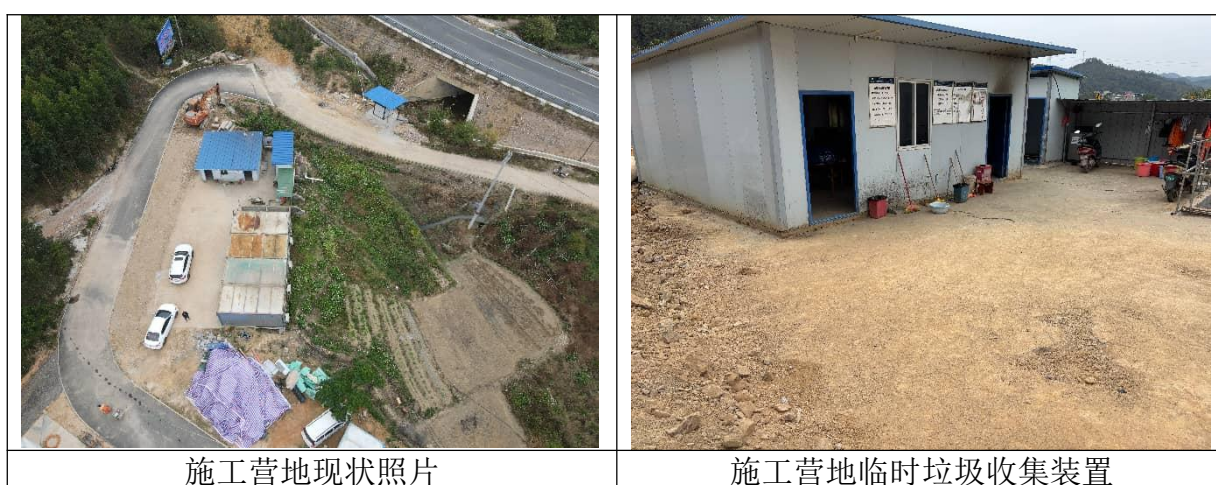
图 2-2 变电站施工营地现状照片
