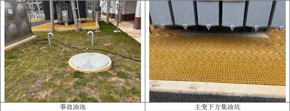
图4-4 本项目事故油池现状
