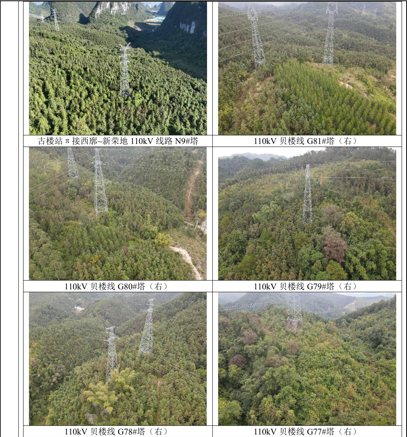
图 2-12 本项目生态保护红线范围内塔基恢复照片
