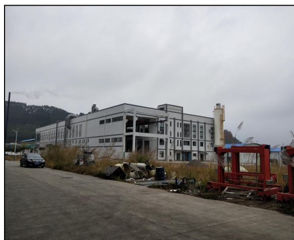
园区污水处理厂
