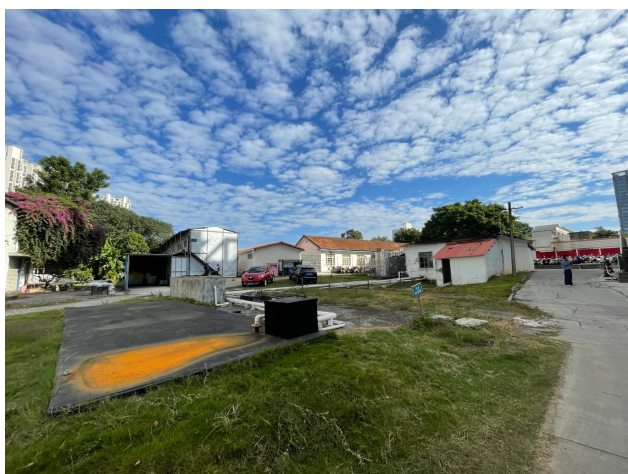
现有污水处理站、事故应急池
