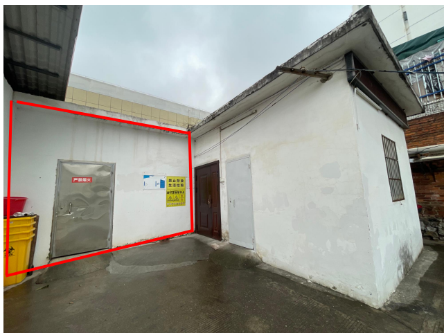
现有危险废物暂存间
