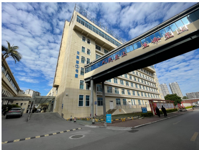
现有综合楼（本次改造）
