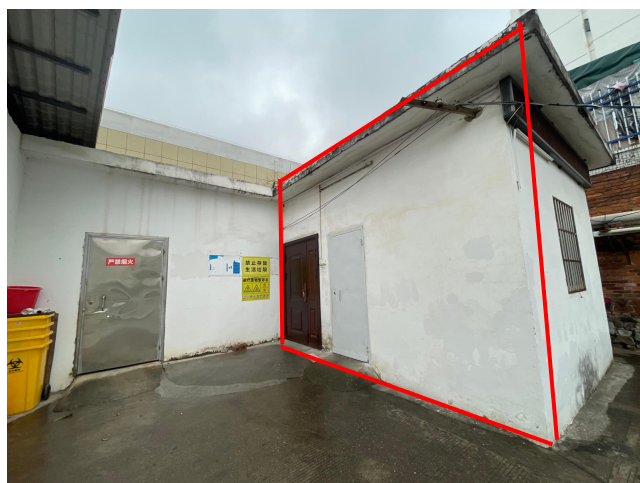
现有医疗废物暂存间
