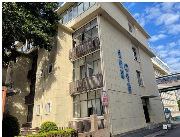
现有住院北楼（本次改造）
