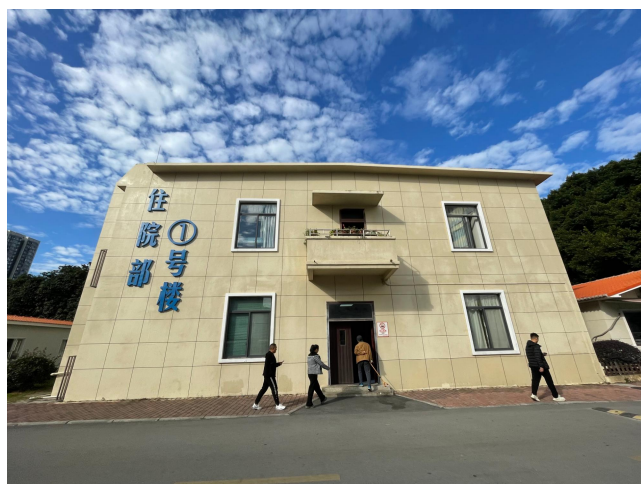
现有住院南楼（本次改造）
