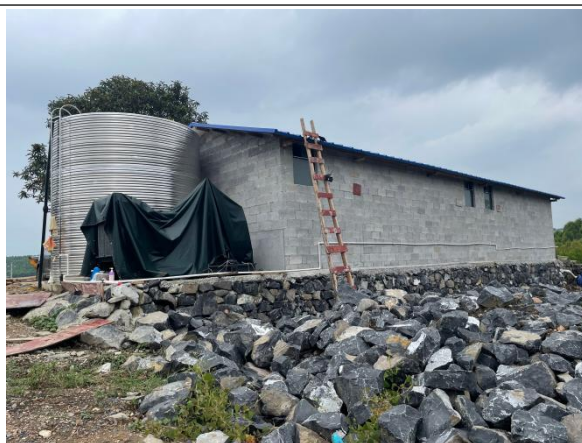
1#辅助管理区现状
