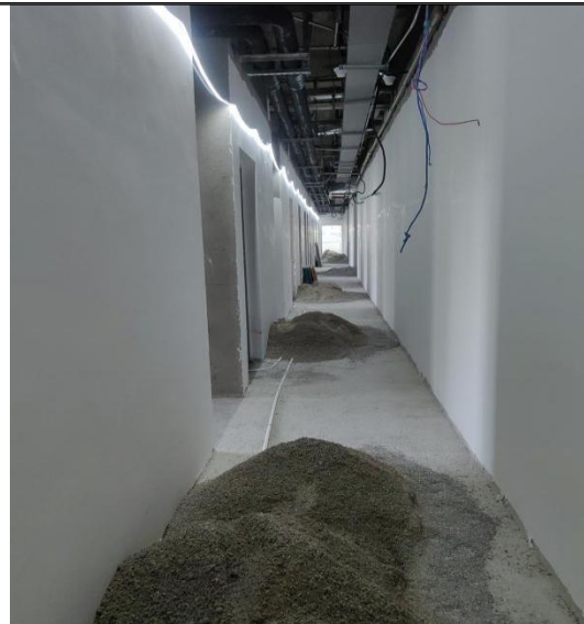
介入手术室南面走廊（洁净廊）
