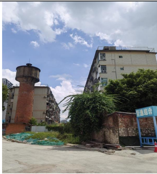
柳州市第二棉纺织厂生活区 (医技综合楼南侧)
