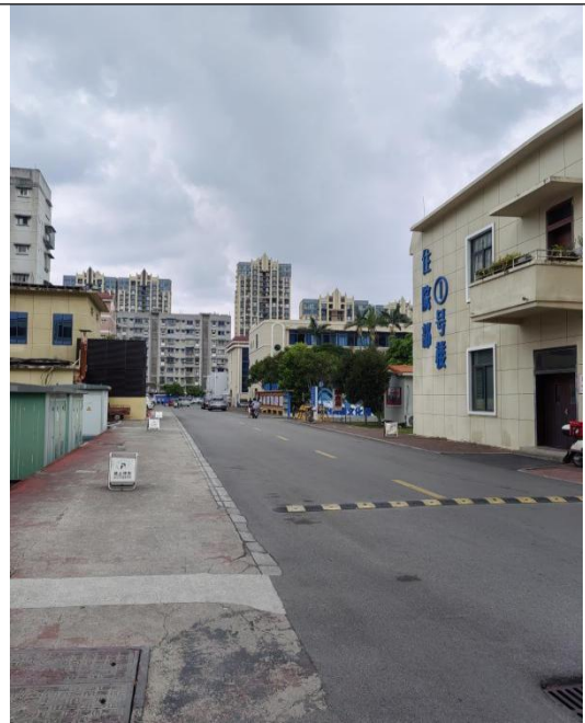
住院部 1 号楼（医技综合楼西南侧）
