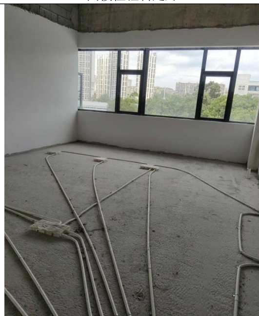
四楼医生办公室现状
