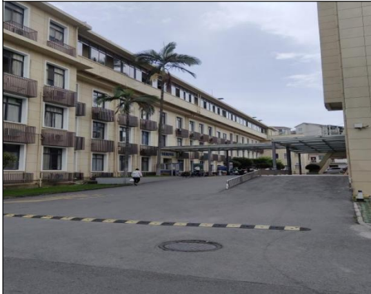
住院楼 2 号楼（医技综合楼西侧）
