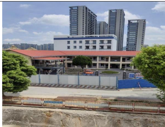
住院部 6 号楼 (医技综合楼东侧)
